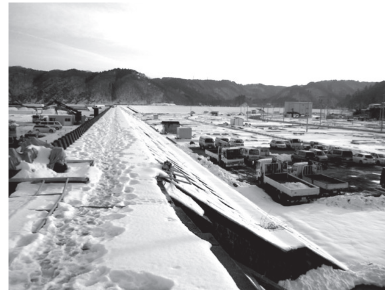
10メートルの高さの田老の防潮堤でも津波は乗り越えてきた
