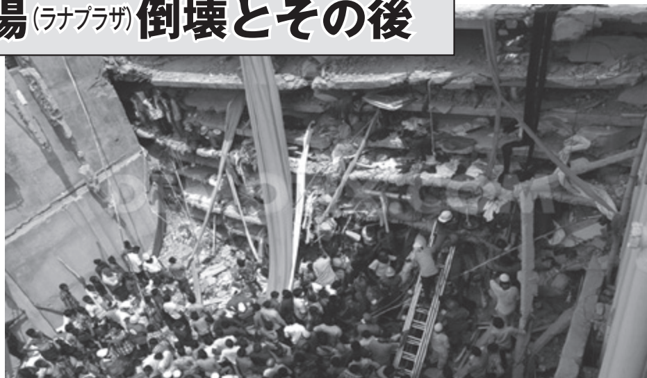
倒壊したラナプラザのビル
