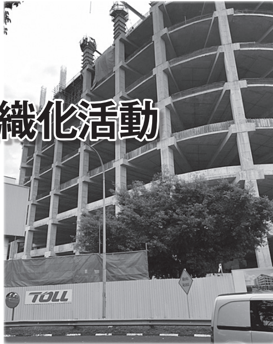
建設中のトールシティの施設
